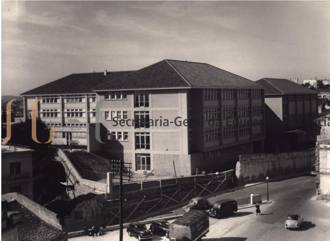
Fig. 2 - Vista exterior, anos 50 do sec. XX (fonte: Base de dados do Atlas da Arquitectura Escolar em Portugal, ASAP-EHC)
