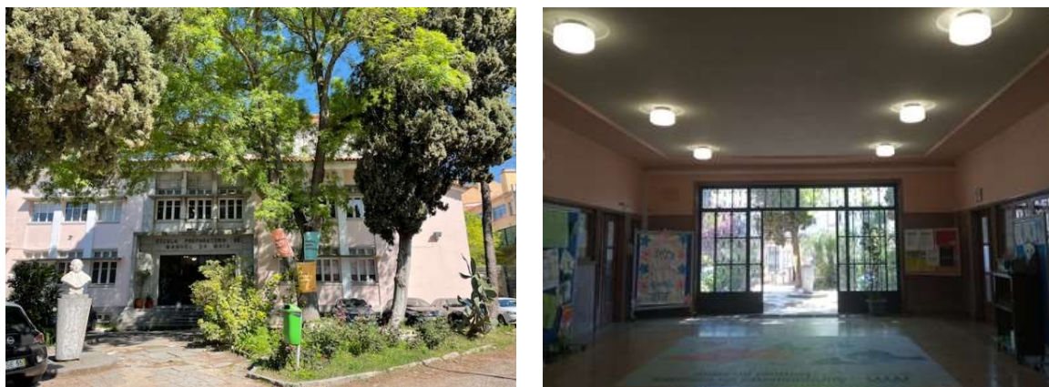
Figuras 16 e 17 - Bloco A de aulas com dois pisos e perspetiva do interior- átrio principal
