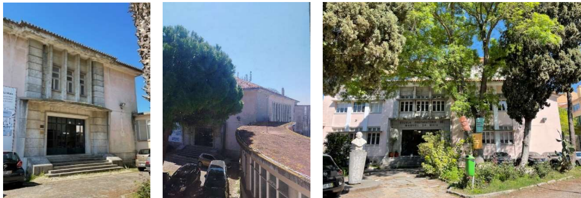
Figura 12, 13 e 14 – Edifício do Ginásio (G), galeria coberta de ligação entre Blocos (C) e edifício de Aulas (A) antecedido por busto de Manuel da Maia;
