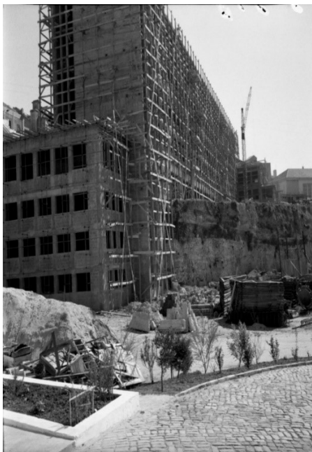
Figura 7 - Imagem do início da construção da Escola
