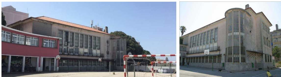
Figuras 27 e 28 – Perspetivas desde o recreio para o Ginásio (Corpo G) com a ligação à galeria coberta (Corpo C) e caixa de escadas do edifício na extremidade oposta, perto da entrada de serviço (imagem do Ginásio desde a (imagem retirada do site da Escola)
