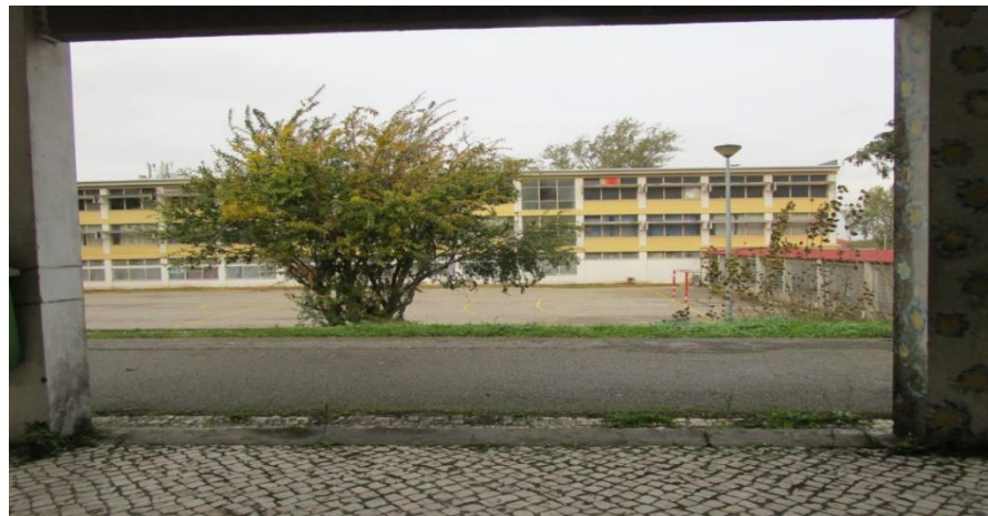
Figura 13 – Corredor de passagem coberto nas oficinas (Bloco O) da Escola Básica e Secundária Luís António Verney
