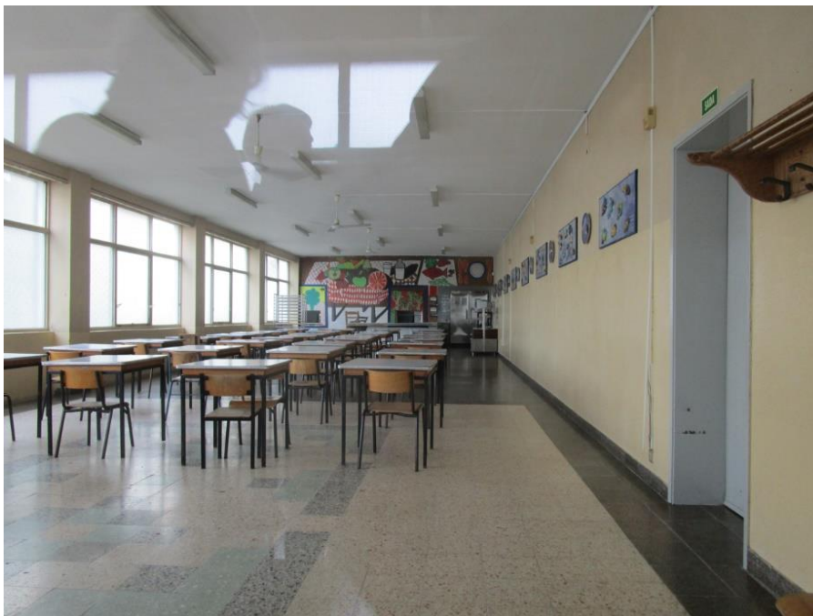
Figura 15 – Refeitório (Bloco G) da Escola Básica e Secundária Luís António Verney
